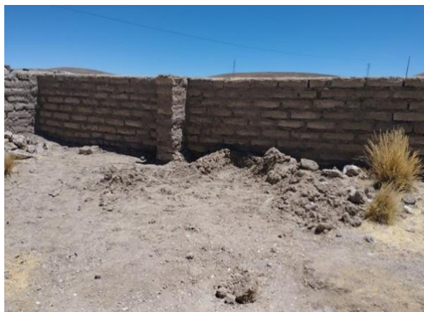
Muro reforzado del centro educativo
