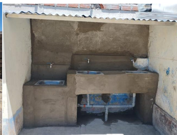
Pileta en construcción del centro educativo
