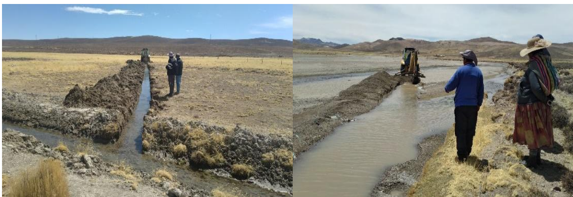
Limpieza de canales de riego de zona ribereños
